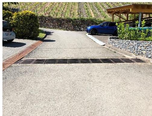
Beispiel breite Überfahrbare Entwässerungsrinne mit breiten Schlitten.
