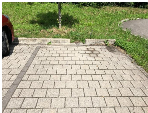
Beispiel gezielte Ableitung von Wasser in Freiflächen
