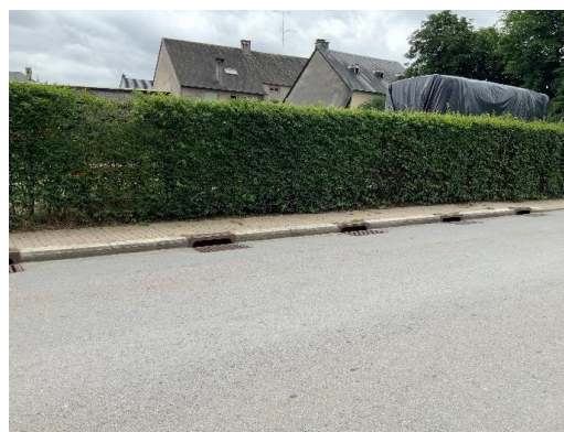
Beispiel an strategischen Stellen mehrere Einläufe positionieren.
