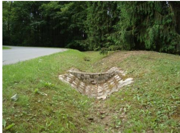
Beispiel Graben mit Querbauwerk zum Rückhalt
