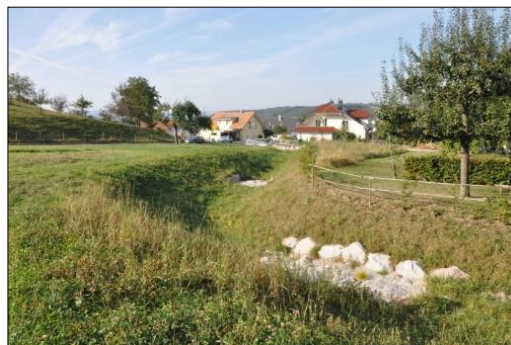
Beispiele großzügig dimensionierter Leitgraben, Wald&Corbe
