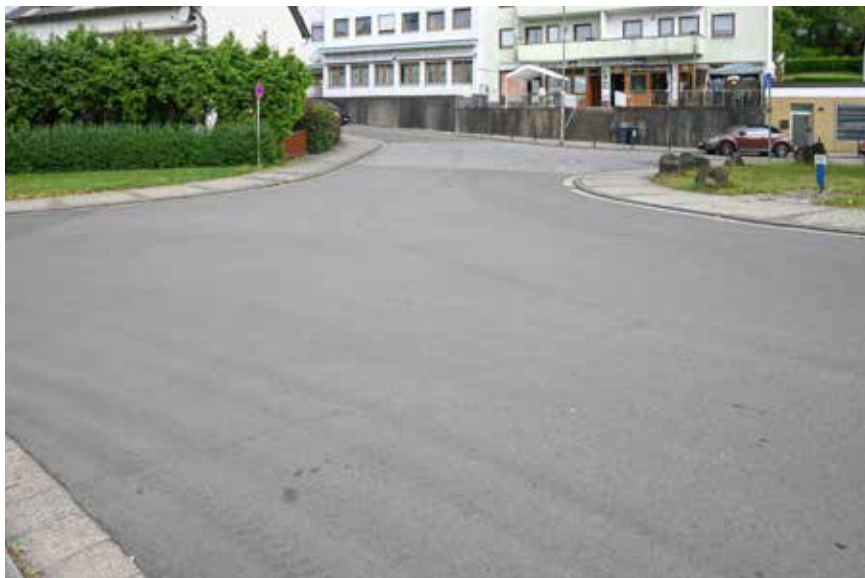
überdimensionierte Straßenräume sowie Straßenführung im Bereich Quierschieder Straße/ Schulstraße
