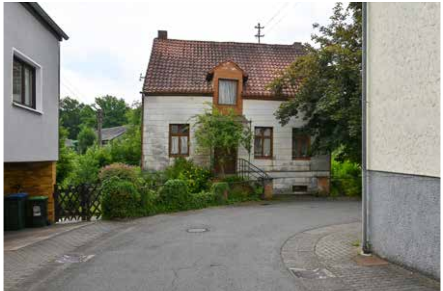
Wohngebäude-Leerstand mit Sanierungsbedarf im Bereich der Winkelstraße
