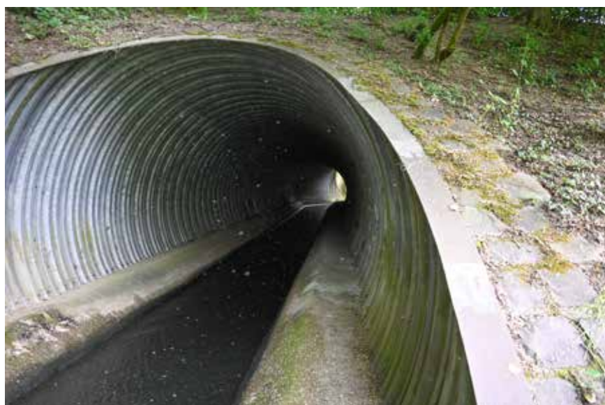
schmaler Brückendurchlass „Am Weierdamm“
