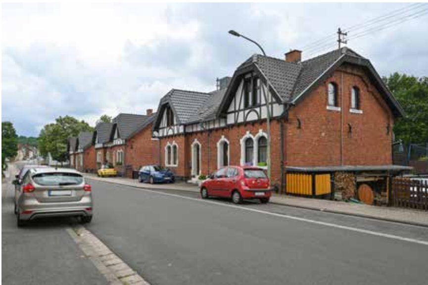
Denkmalgeschützte ehem. Arbeiterwohnhäuser im Bereich der Quierschieder Straße mit Sanierungsbedarf
