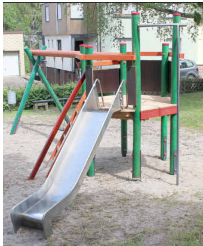
Der Spielturn in der Wilhelmstraße wurde saniert.
