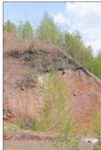
Istzustand Halde nördlich Fischbachbahn
