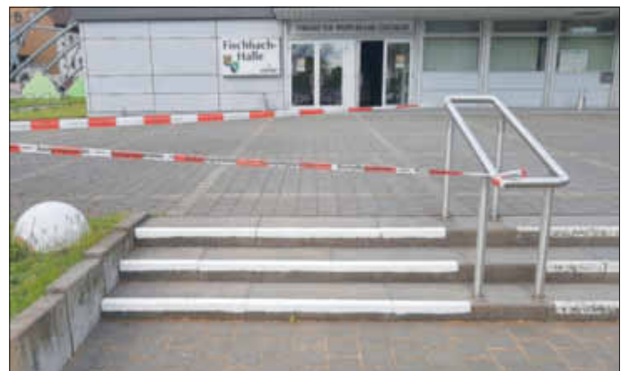
Treppe zur Fischbachhalle
